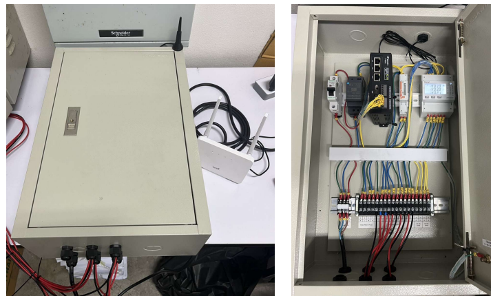
รูปที่ 3 ชุดประมวลผลและแสดงผลการวัดพลังงานไฟฟ้าที่ติดตั้งจริง
