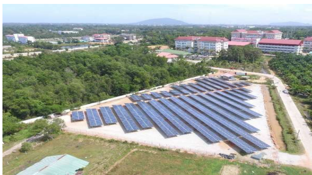
ภาพที่ 1 ระบบผลิตพลังงานไฟฟ้าจากเซลล์แสงอาทิตย์ขนาด 500 kW
