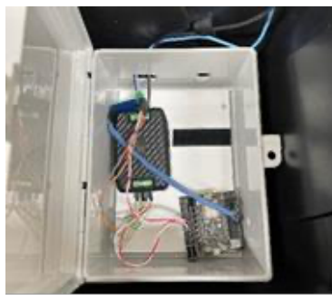
ก) ติดตั้งบอร์ด PZEM-016
