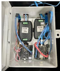
ก) ติดตั้งบอร์ด PZEM-017 ไว้ในกล่องอุปกรณ์
