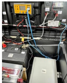
ข) ติดตั้งกล่องอุปกรณ์ ไว้ด้านในกล่องสำรอง พลังงานไฟฟ้า
