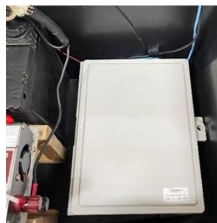
ข) ติดตั้งกล่องอุปกรณ์ไว้ข้างใน กล่องใช้งาน
