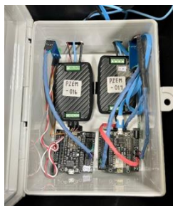
ก) ติดตั้งบอร์ด PZEM-017 ไว้ในกล่องอุปกรณ์
