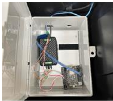
ก) ติดตั้งบอร์ด PZEM-016
